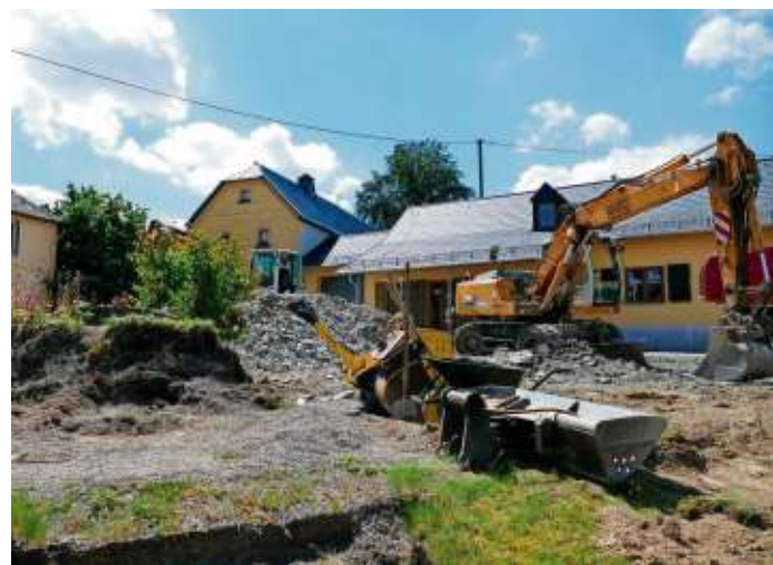
Die Bauarbeiten zur Vorplatzgestaltung im Berger Ortsteil Bug haben begonnen.
