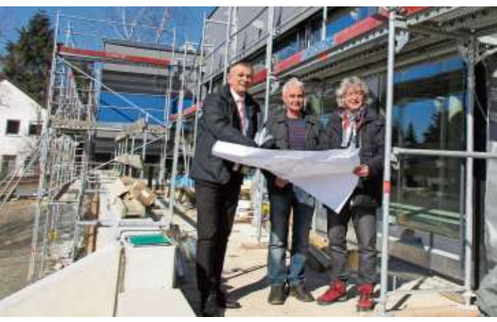
1. Bürgermeister Frank Stumpf und Stadtbaumeister Reiner Franz informieren sich bei Architekt Gernot Heinz (von links) über den Baufortschritt.
