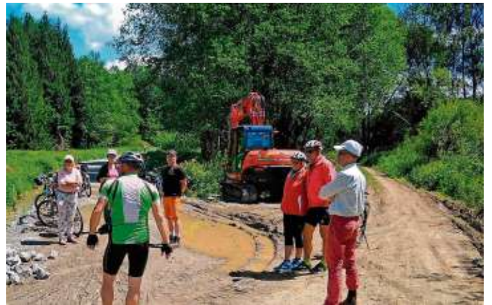
Drei Brückenbauwerke sind in diesem Abschnitt im Bau.
