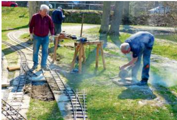
Die Gleisanlage des Modellbauvereins Naila - Parkeisenbahn Froschgrün wird zurzeit verbessert und erweitert. Auf die Aktiven des Vereins kommt damit viel Arbeit zu.
