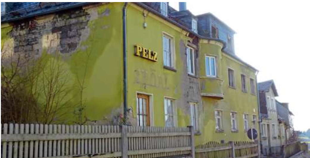
Gebäude Pelz-Spörl kurz vor dem Abriss.
