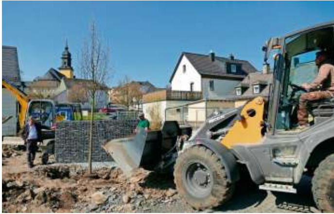
Das Foto zeigt die Pflanzaktion der fünf Meter hohen Winterlinde, die Bürgermeister Helmut Oelschlegel beobachtet. Im Radlader sitzt Vorarbeiter Andreas Cosolo, der den Humus ins Pflanzloch kippt.
