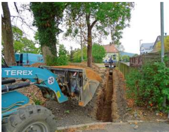
Zum Sudetenring wurde eine Wasserleitung gebaut.
