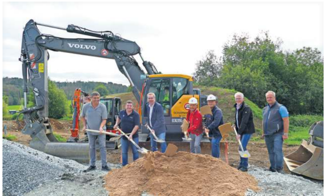
Symbolischer Spatenstich für das Sechs-Millionen-Euro-Projekt zur Einführung des Trennsystems im Abwasserbereich und teilweise Neubau der Wasserversorgung im Bad Stebener Ortsteils Carlsgrün. Das Bild zeigt (von links) von der Bauverwaltung der Marktgemeinde Klaus Rehm und Bauamtsleiter André Möller, Bürgermeister Bert Horn, Chef der Baufirma Jürgen Scharnagl und Bauleiter Rico Schneider und vom Planungsbüro US-Consult aus Naila, Chef Ralf Büntig und Bauleiter Frank Lailach.
