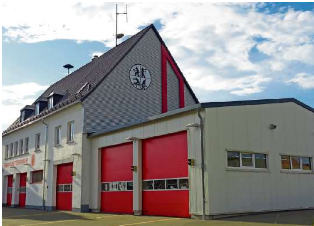
Beim Feuerwehrhaus der Stützpunktwehr in Schwarzenbach a.Wald wurde vor kurzem einiges saniert. Eine neue Dacheindeckung mit Betondachsteinen wurde von der Firma Eckstein durchgeführt. Ebenso einige Fenster und die Fassade mit Wellblech – in rot abgesetzt – und dem Feuerwehrlogo: retten-löschen-bergen-schützen. Die Investition betrug fast 62.000 Euro. Im Innern besteht weiterer Bedarf.
