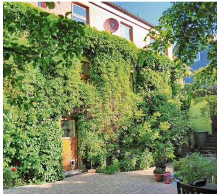
Der Efeu ist, durch seine Eigenschaft das Blätterkleid auch im Winter zu tragen, der ideale Klimavorhang für die Fassade. Hier eine restaurierte Hauswand in Naila. Der bestehende Efeu und wilder Wein wurde bei der Fassadenerneuerung bewusst erhalten und nicht entfernt.
