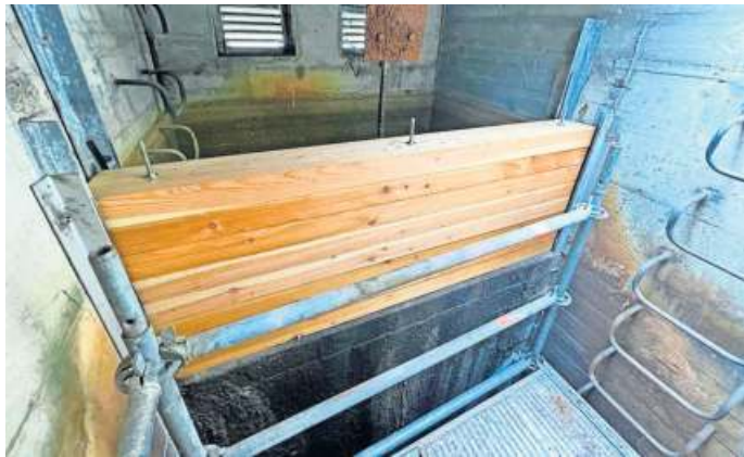
Ein Blick in das „Innere“ des Mönch nach erfolgter Reparatur.
