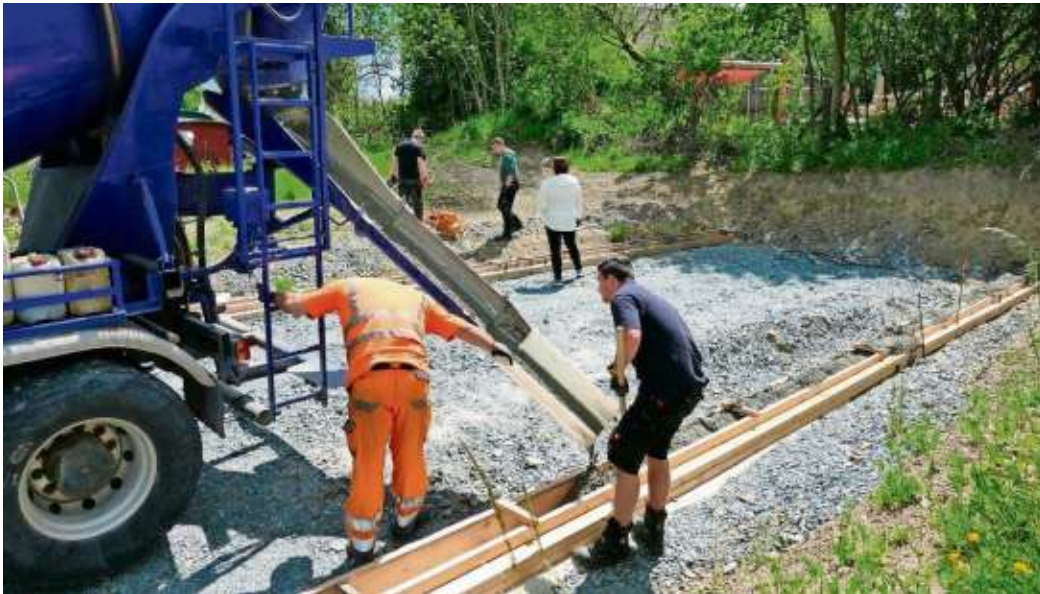
Nils Färber und Holger Welte (von links) werkelten beim Arbeitseinsatz zur Fundamenterstellung mit.
