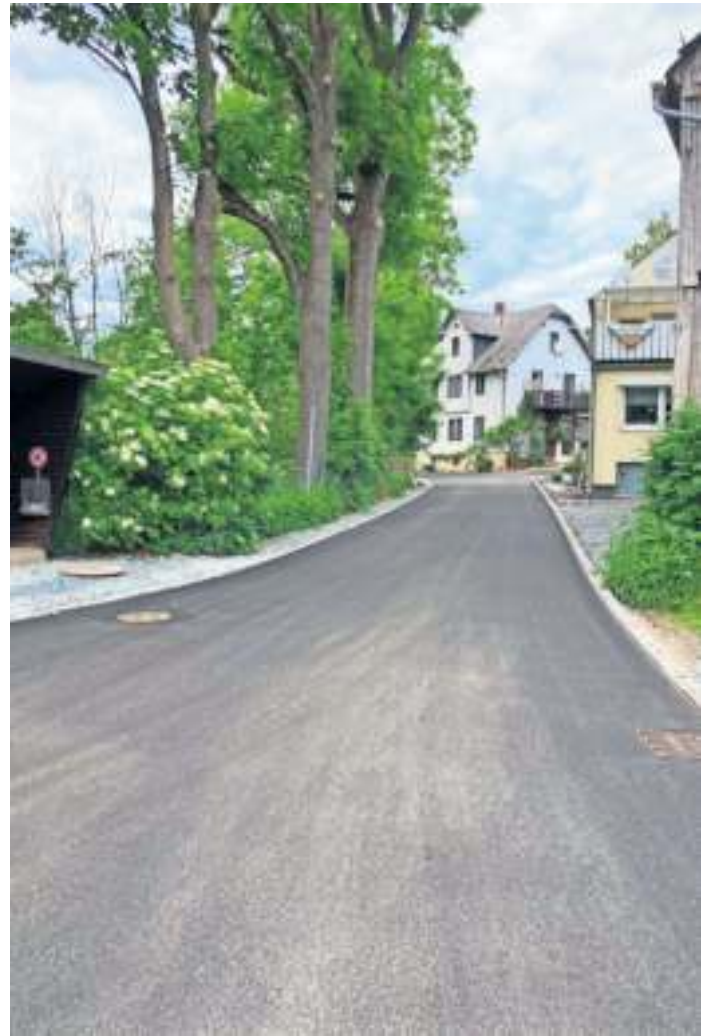
Das Bild zeigt den Straßenbau „An der Schmiede“ in Gottsmannsgrün.
