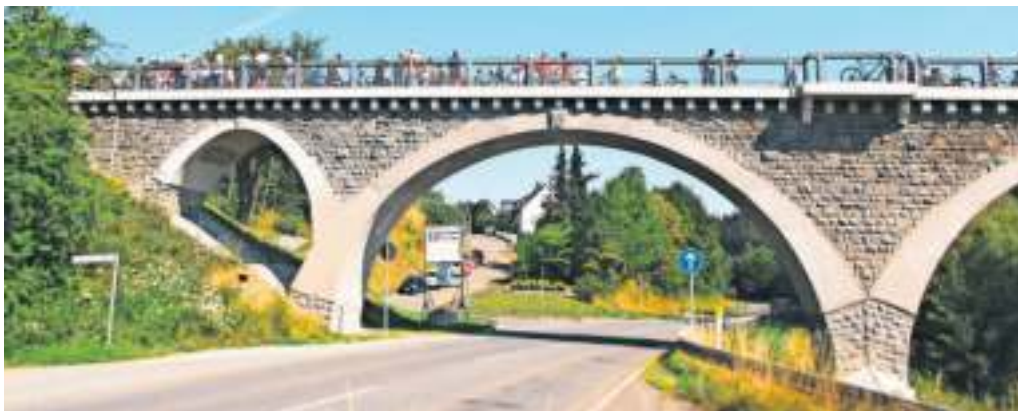
Die Bogenbrücke in Naila ist beim Tag des offenen Denkmals dabei.
