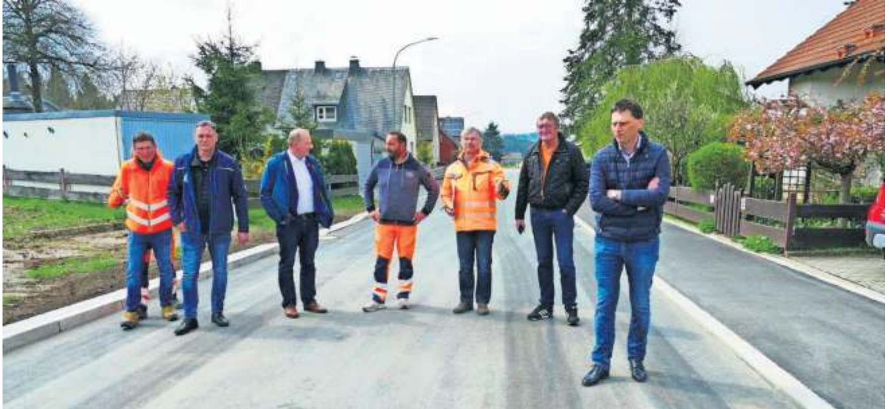
Unser Bild zeigt die Begehung zur finalen Abnahme.
