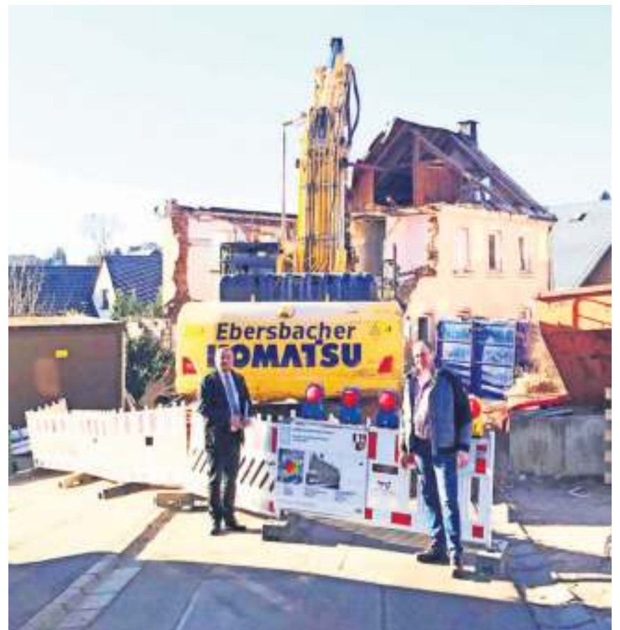
Das Foto zeigt 1. Bürgermeister Frank Stumpf und Harald Ernst vom Bauamt Naila auf der Baustelle in Marlesreuth.
