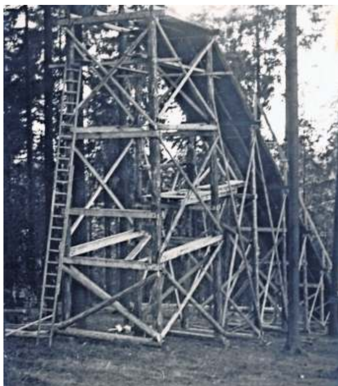
Bau des Schanzentisches im Jahr 1951
